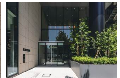
■1F事務所エントランスアプローチ
